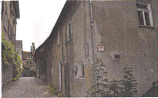
In der Mühlgasse 10 stand das ehemalige Armenhaus jahrelang leer.
